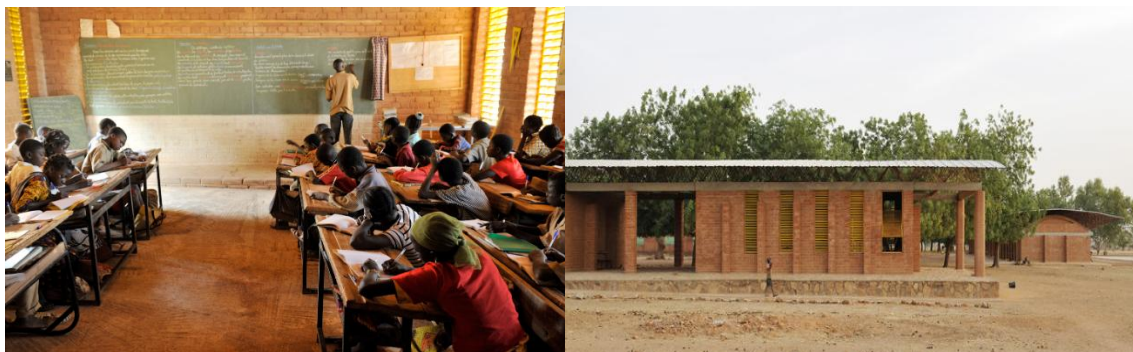
Figura 01 e 02 - Escola Primária em Gando
